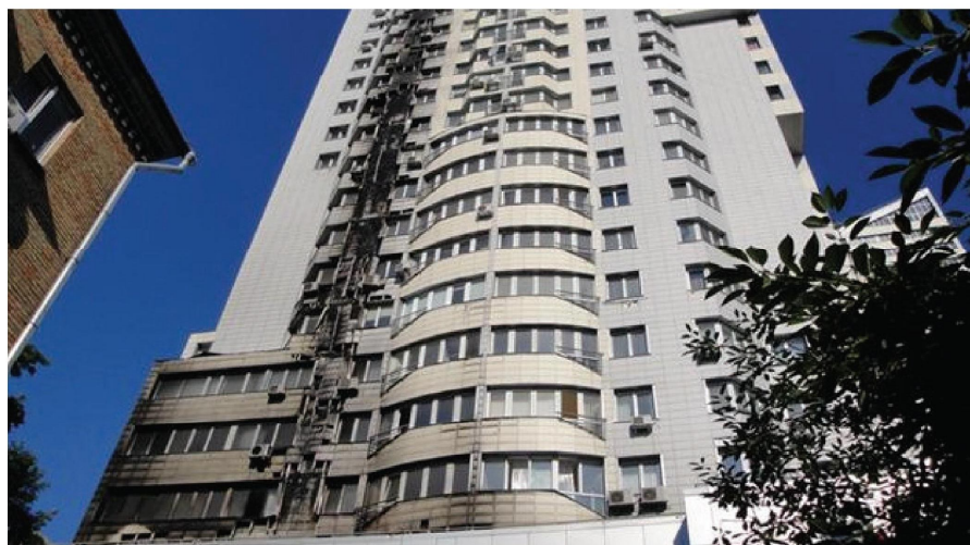
Фото 5. Пожар в Киеве
