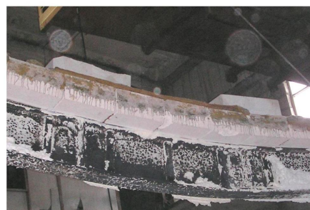
Фото 10. Вид стальной балки с огнезащитной краской после испытаний на огнестойкость
