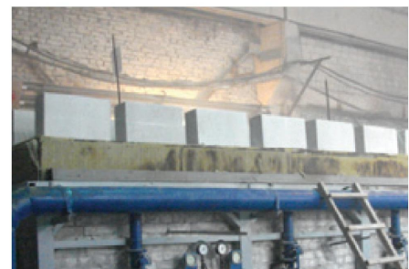
Фото 11. Испытание кровельного настила под снеговой нагрузкой
