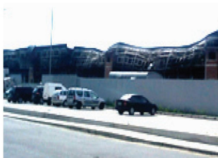
Фото 1 Обрушение покрытия логистического центра в результате пожара
