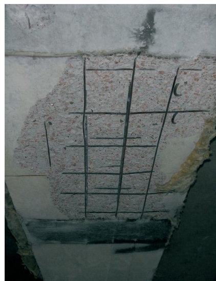
Фрагмент залізобетонного перекриття
