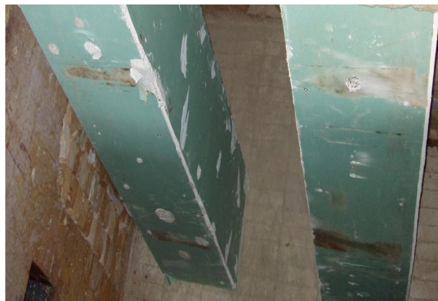
Рис. 8. Вид образцов железобетонных колонн в печи с облицовкой из гипсокартона
