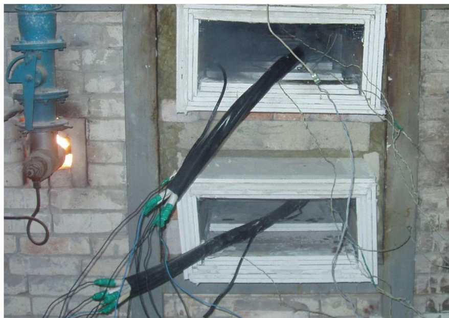
Рис. 7. Испытание кабельной линии в коробе из гипсокартонных плит
