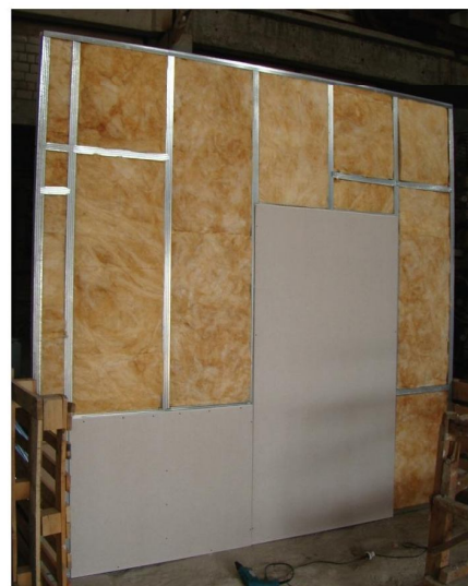
Рис. 5. Монтаж образца перегородки для испытаний
