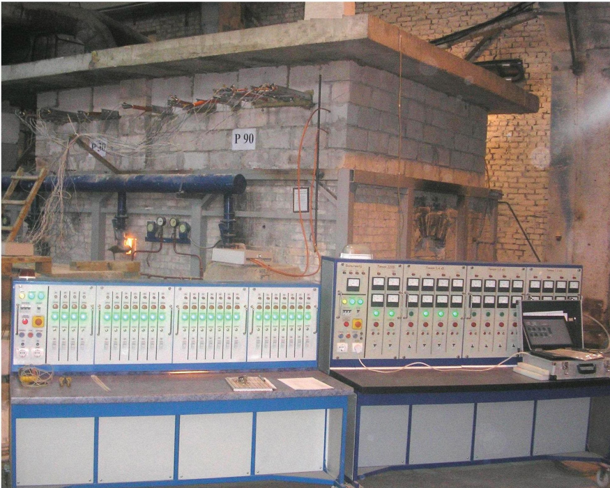
Комплексне випробування кабельних ліній на вогнестійкість
